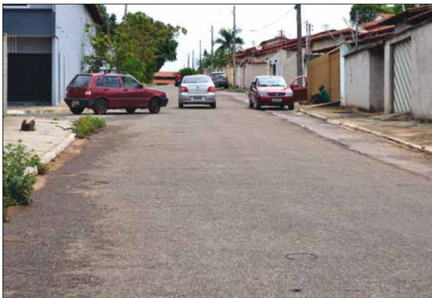
Pavimentação asfáltica de vias do setor Sul, em Uruaçu: obra vital de infraestrutura viabilizada por Jovair Arantes
