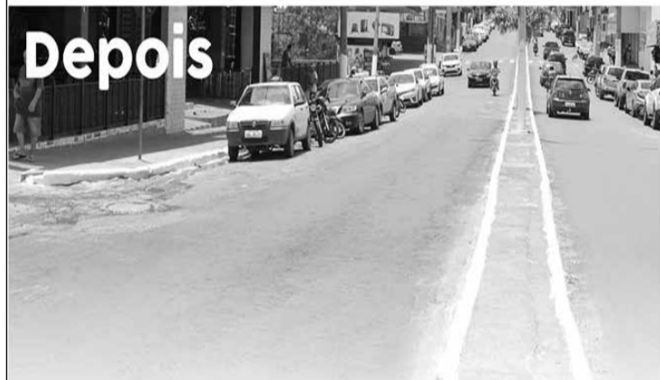
Governo 2017-2020 herdou cidade completamente esburacada. Operação desenvolvida de forma responsável. Um dos ápices da gestão que se inicia serão investimentos em pavimentação
